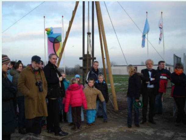
2007 Bouw Lichtboog: 1e paal geslagen door Martine Bakker.
